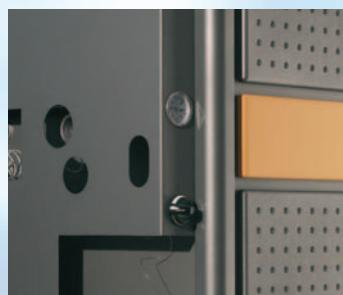
**Termoregulador y termómetro: para configurar y comprobar la temperatura de envío del agua caliente a la instalación.**
